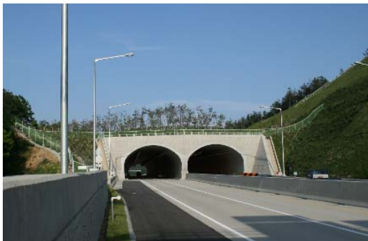
그림 2-15. 개착식 터널의 정면 모습
