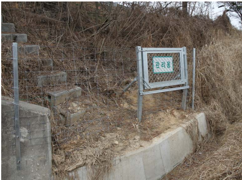
그림 3-16. 유도울타리의 출입문 설치 사례
