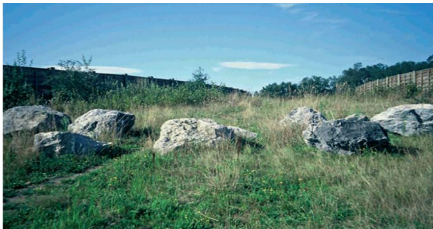
그림 2-29. 차량의 통행을 막기 위해 생태통로 진입부에 암석을 배치한 모범사례 (출처:luell et al, '03.유럽위원회)의 생태통로 해설서, 사진: H. Bekker)
