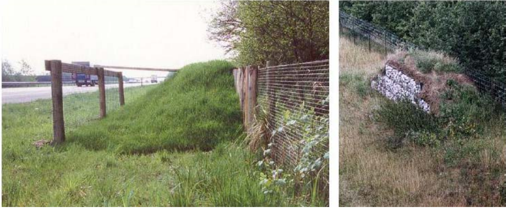
그림 3-13. 탈출용 경사로 설치 사례
