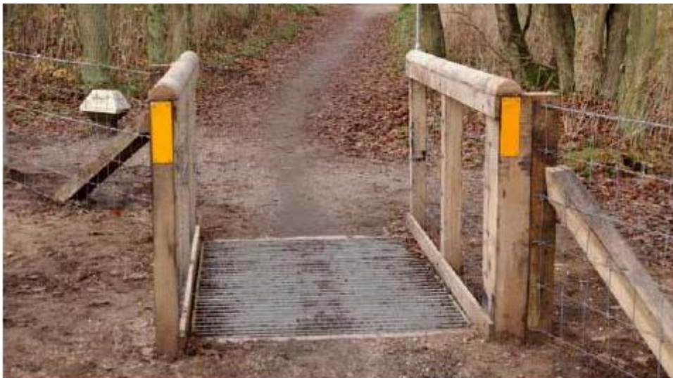
그림 3-22. 산책로의 출입문을 대신하여 설치한 침입 방지 노면 (출처: Kruidering et al., 2005. 네덜란드의 생태통로 지침서)
