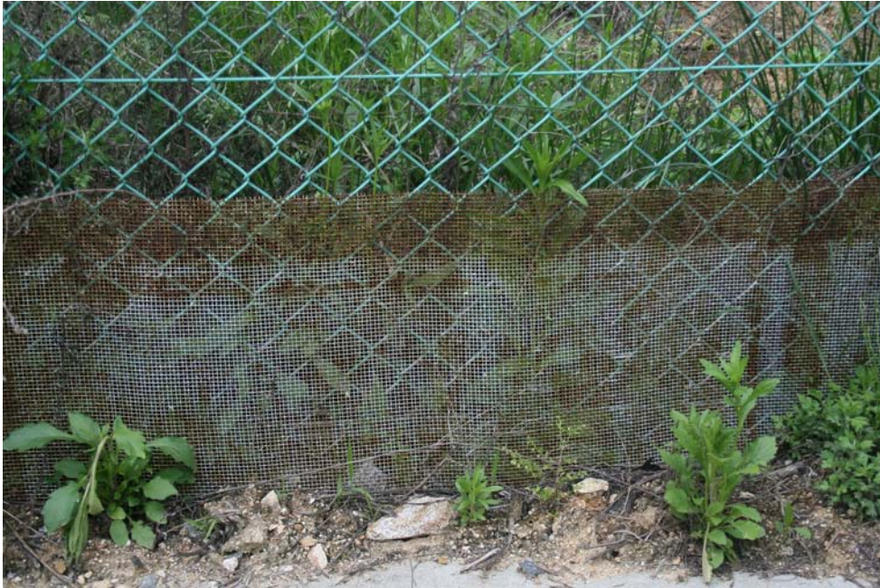
그림 3-29. 코팅이나 도금이 부실한 제품을 사용할 경우 녹이 슬어 내구성과 미관을 크게 훼손할 수 있으므로 주의해야 한다.
