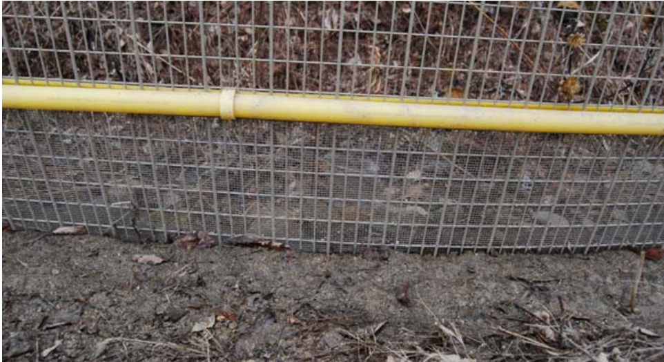
그림 3-27. 포유류와 양서·파충류 울타리가 일체형으로 제작된 제품을 설치한 사례
