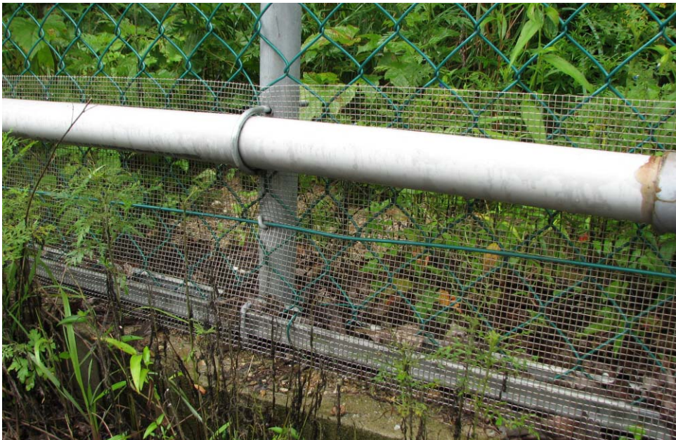
그림 3-28. 능형 울타리 하단부에 조밀망을 덧대고 반원형 PVC 파이프를 달아서 양서·파충류 울타리를 설치한 사례 (조밀망과 PVC 파이프를 풀밭이 있는 능형망 밖으로 설치하였어야 옳음, 사진은 방향이 잘못된 사례임)
