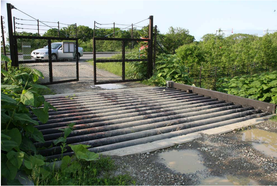
그림 3-21. 임도 진입부에 설치한 동물 침입방지 노면 (장소: 일본 홋가이도 Shari 에코로드)
