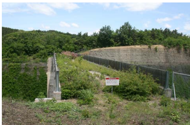
그림 2-8. 중앙부 폭 7m의 육교형 생태통로 (위치: 대구·포항간 고속도로)
