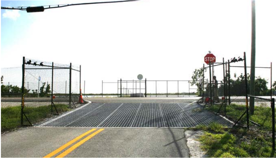
그림 3-19. 교차로에 설치된 침입 방지 노면 (장소: 미국 플로리다주 키웨스트)
