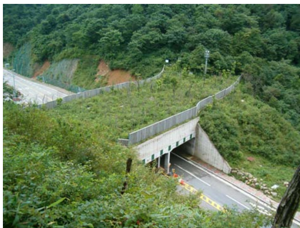
그림 2-7. 중앙부 폭 30m의 육교형 생태통로 (위치: 국도 56호선 구룡령 생태통로)
