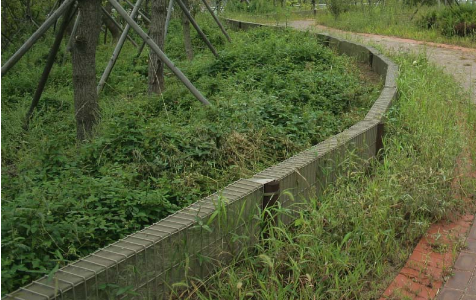
그림 3-25. 양서·파충류 전용 울타리를 설치한 사례 1
