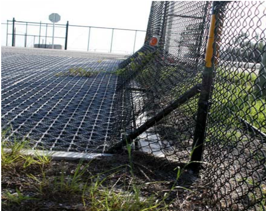
그림 3-20. 울타리와 그레이팅 경계부를 따라 들어오는 것을 방지 하기 위해 대각선으로 덧대어 설치한 울타리 하단부(장소: 미국 플로리다주)
